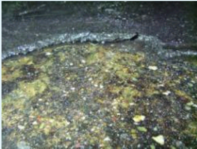
Dicke Verkrustungen stellten bei der Sanierung des Werkstattbodens eine echte Herausforderung dar. Bild: Cleaning Concepts
