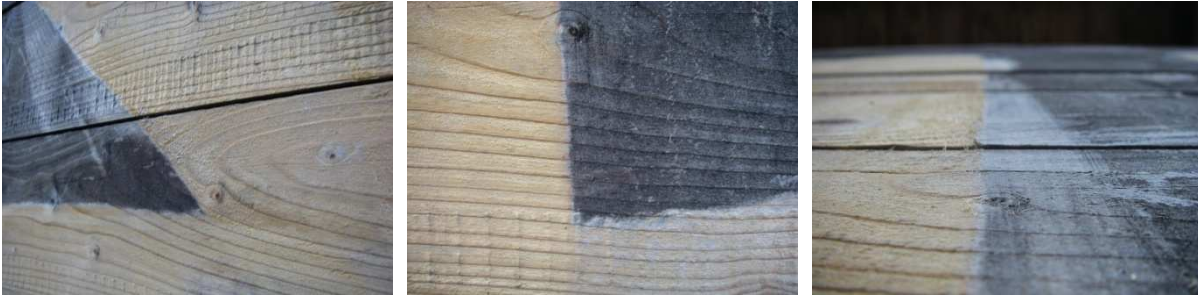
Reinigung einer Holzwand auf einem Lagerplatz
